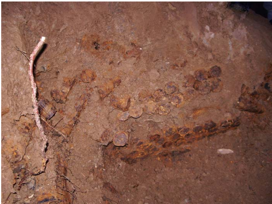
金属探査により反応点を確認しながら掘削した状況 (塊で現れたあか筒と思われる物体)
