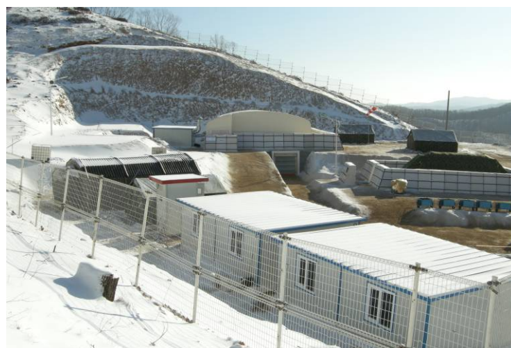
1号坑側より撮影
