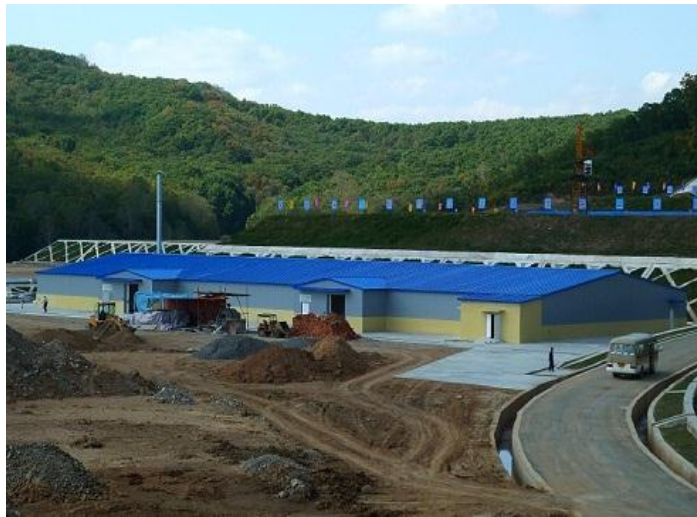
汚染物倉庫(9月)
