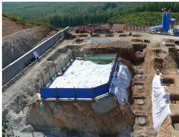
2号発掘棟建設予定地(9月)
