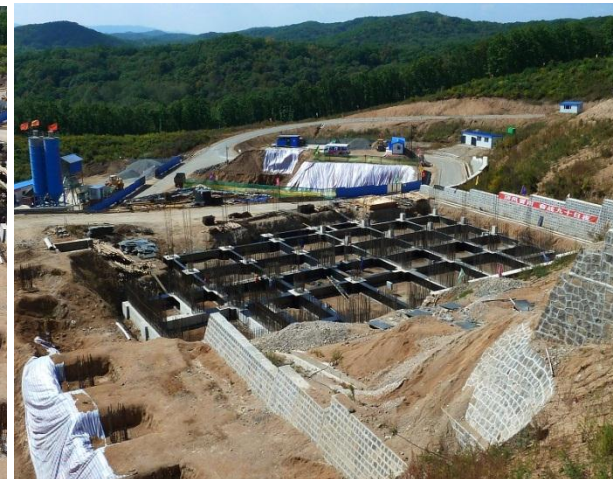
回収棟建設予定地(9月)
