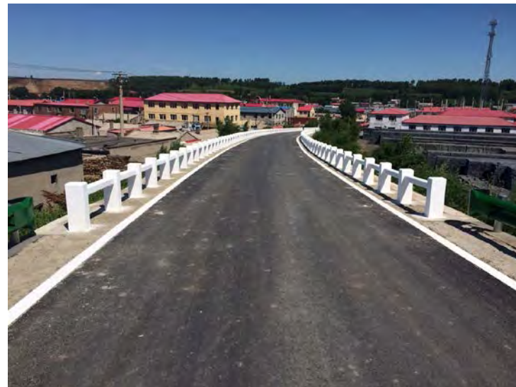
場外アクセス道路の完成状況
