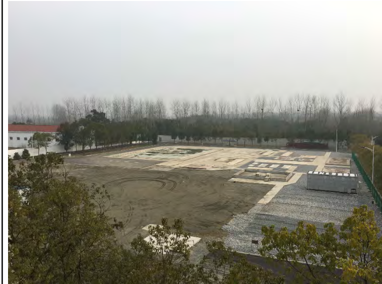
武漢処理場(処理設備撤去後)
