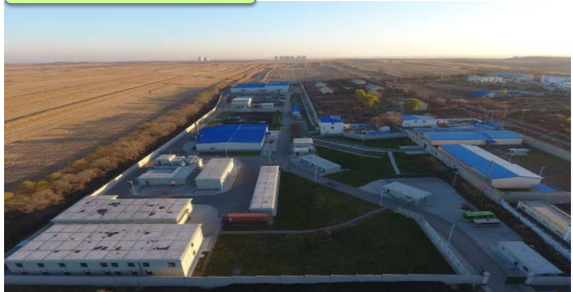
ハルビン処理場全景
