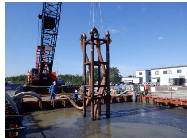
覆土除去装置の機能確認試験
