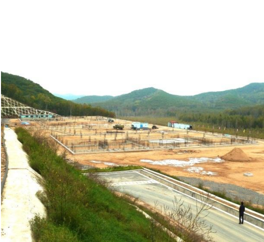
設備収納庫（基礎）工事完了
