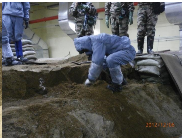
掘り出し作業
