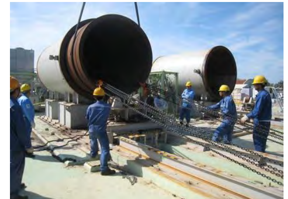
チャンバー内筒引き抜き
