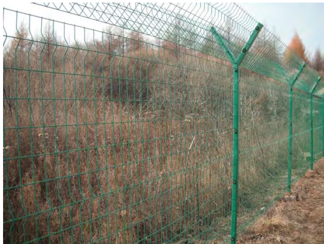
外柵の設置(H25.10月)
