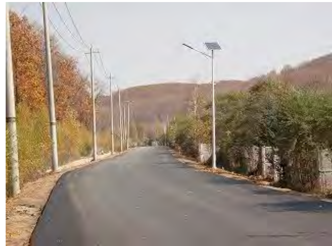
ソーラー外灯設置(H25.10月)
