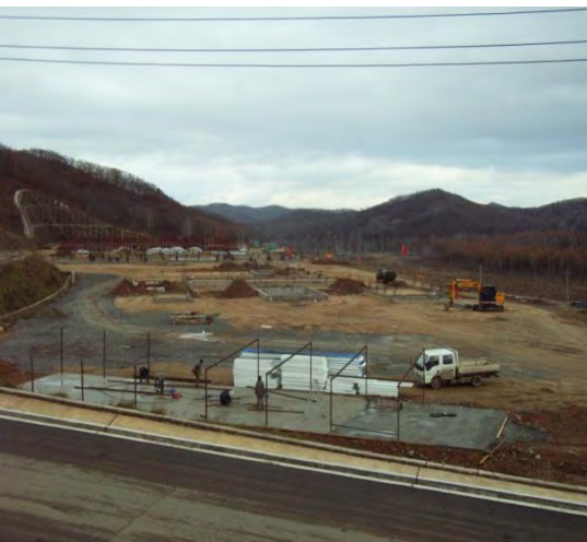
設備収納庫（上屋）工事中
