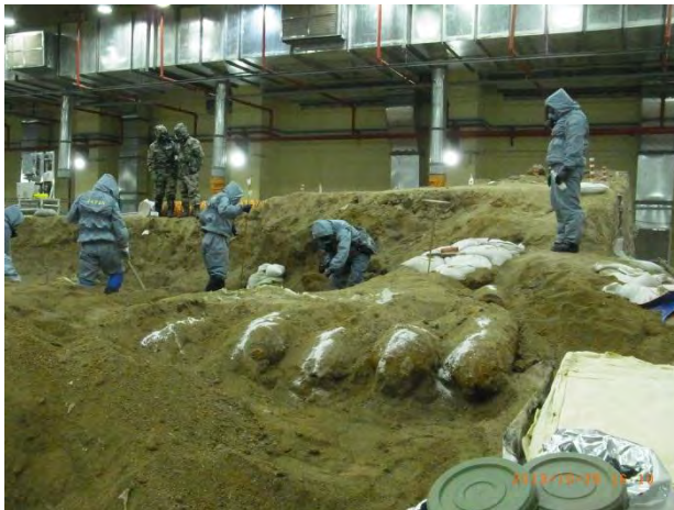
500ポンド爆弾の埋設範囲の調査
