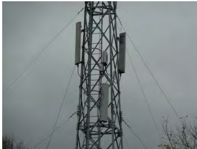
移動通信のアンテナ設置(H25.10月)
