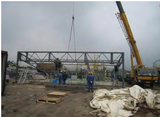
テントの鉄骨解体
