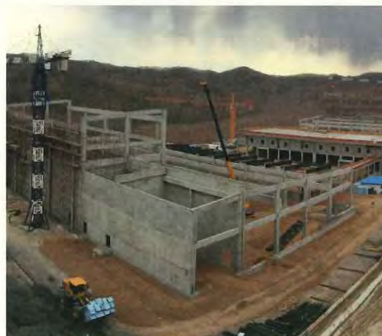
設備収納庫(上屋)工事中 (制御爆破処理施設の状況)
