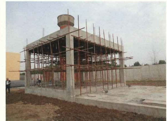
③ 消防水槽Ⅰ期工事
