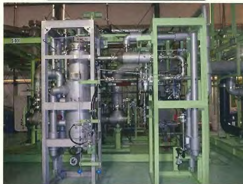
【設備改造の完成状況写真】
