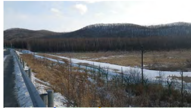
10kV電力工事用 用地造成整備状況
