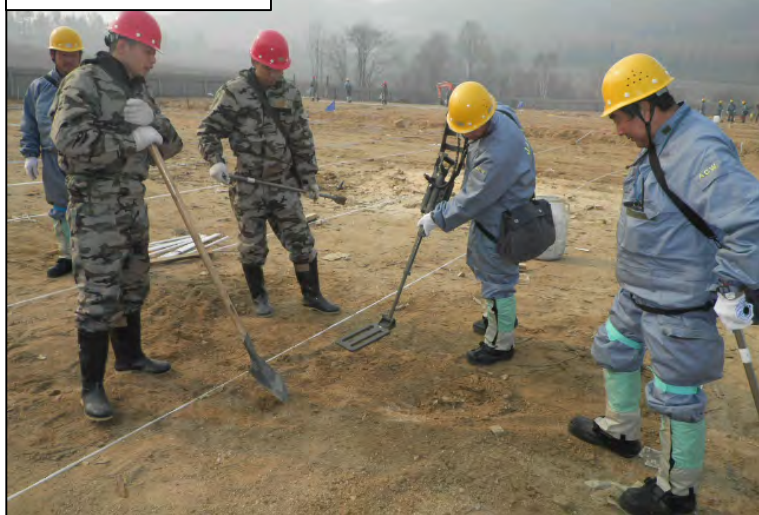
金属探査の状況
