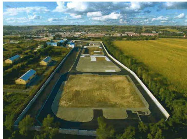
敷地造成及び場内道路等の完成状況
