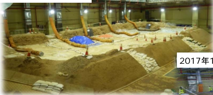
1号発掘棟内部
