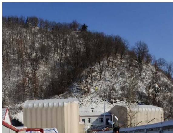
保管庫(テント)の外観
