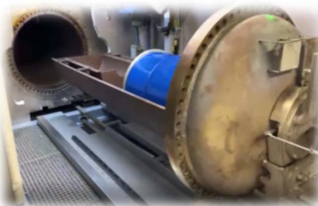
高機動処理設備 II 型 きい剤補給容器(200Lドラム缶)装荷
