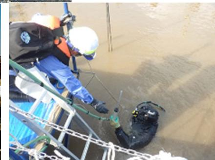
潜水工法(潜水士による発掘)
