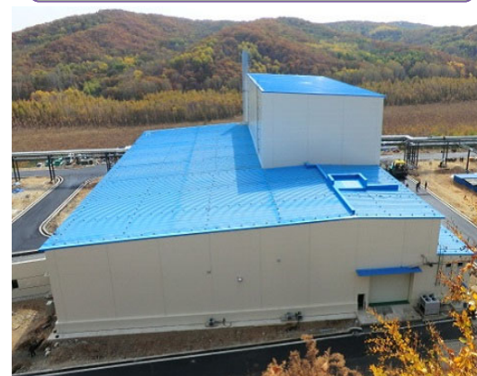
加熱爆破処理施設
