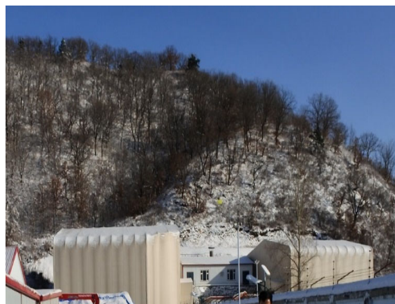
保管庫(テント)の外観
