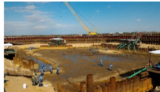
締切工法(ドライアップ後の河川締切りの状況)
