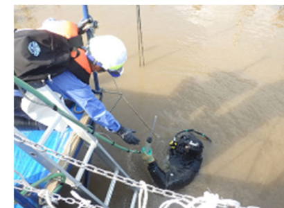
潜水工法(潜水士による発掘)
