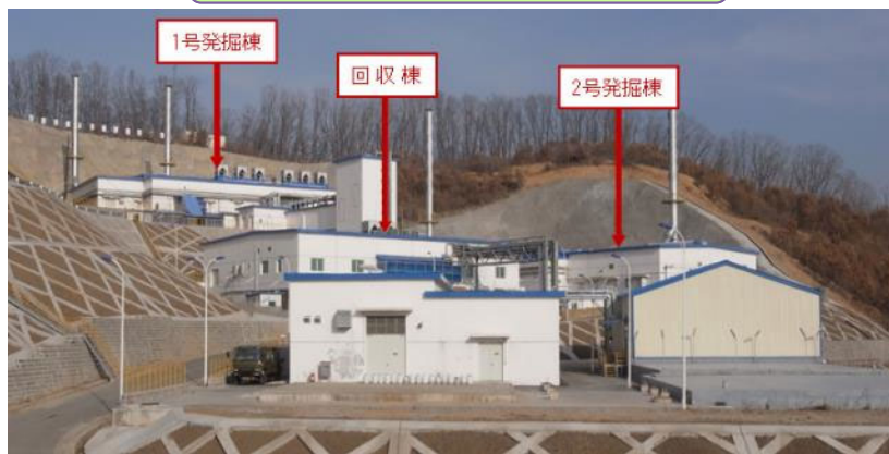
発掘・回収施設
