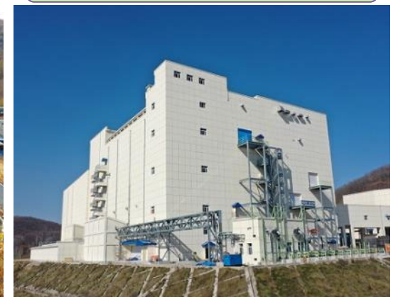
大型廃棄処理施設
