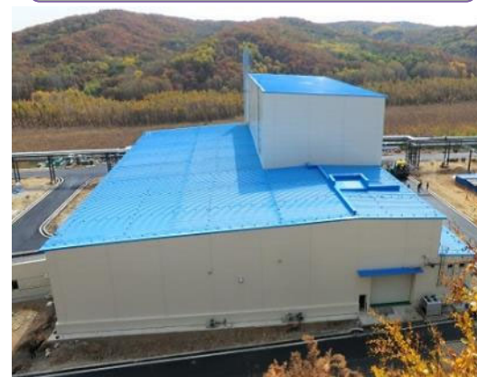
加熱爆破処理施設
