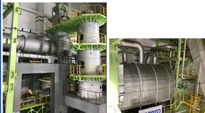
【ロータリーキルン】 （固体廃棄物(ウエス、こん包材など)を処理する)
