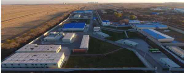
ハルビン処理場全景
