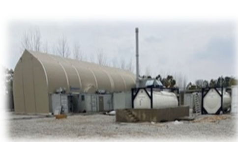
展開した設備全景(概要) 後方は処理設備の格納テント
