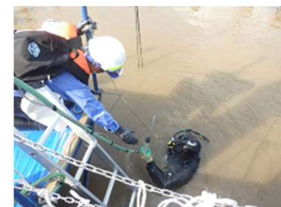
潜水工法(潜水士による発掘)
