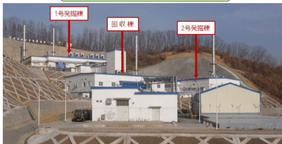
発掘・回収施設
