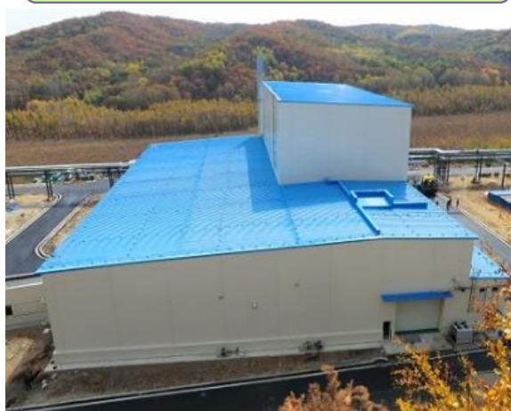
加熱爆破処理施設
