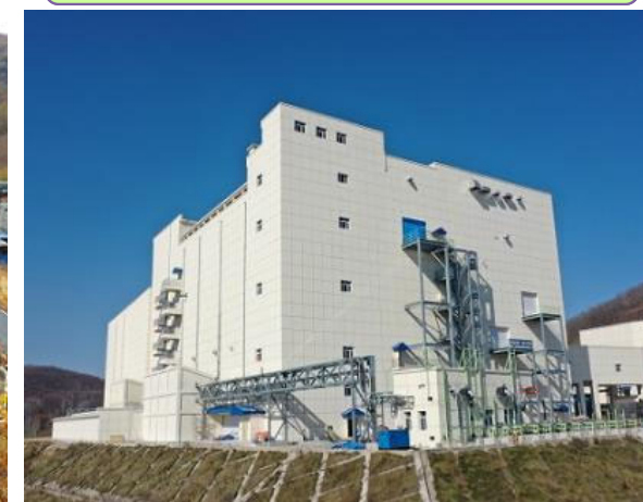
大型廃棄処理施設
