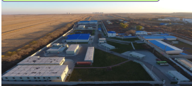
ハルビン処理場全景
