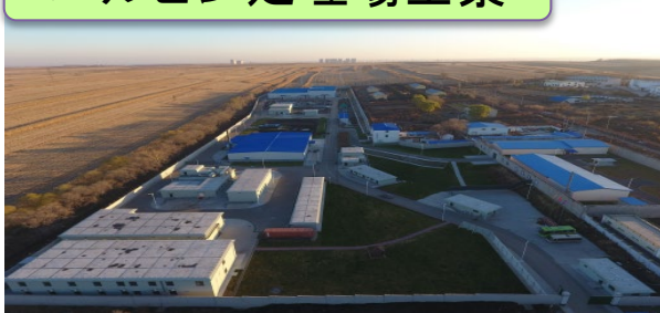
ハルビン処理場全景
