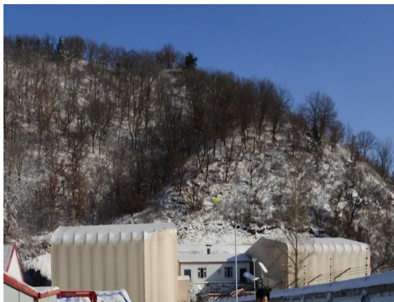
保管庫(テント)の外観
